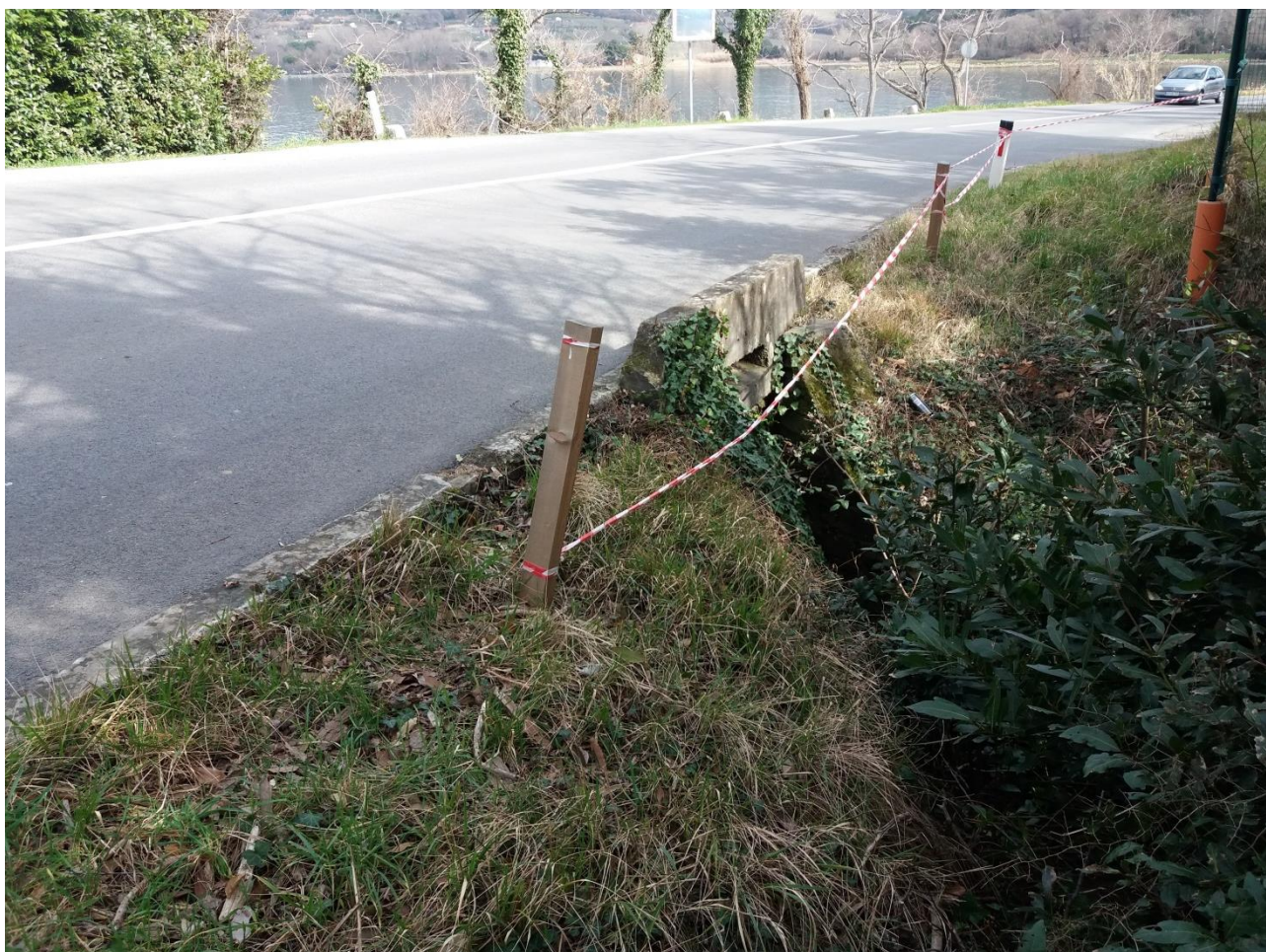
Slika 4: Vtok škatlastega prepusta 84 \times 160 cm v km 7+182
