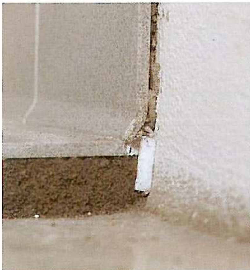
Slika 4: Primer vgradnje dilatacijskih fug s podložnim materialom ob kotnem stiku ob uporabi ustrezne kotne ploščice
