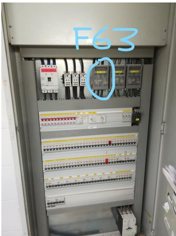
Slika 1: Obstoječi kuhinjski el. razdelilec in varovalni element F63 kamor se priključi dovodni kabel za nov pomivalni stroj
