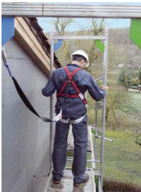
Slika: Varovanje proti padcem v globino v času montaže in demontaže odra obvezno z varnostnim pasom. Uporaba pasu obvezna tudi vedno, ko ni ograje na odru., itd.
