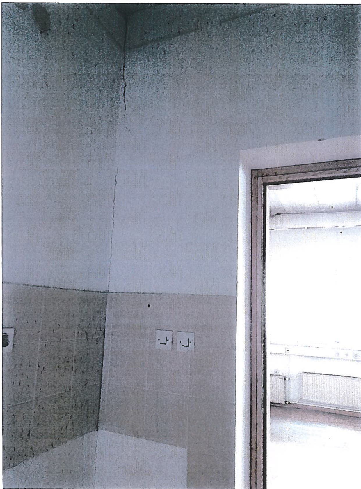
Razpoke v predelnih stenah
